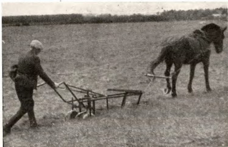
Renseren forspændt en Hest. Konstruktionen af Trækket muligør, at Hesten kan gaa i god Afstand fra Renden.
