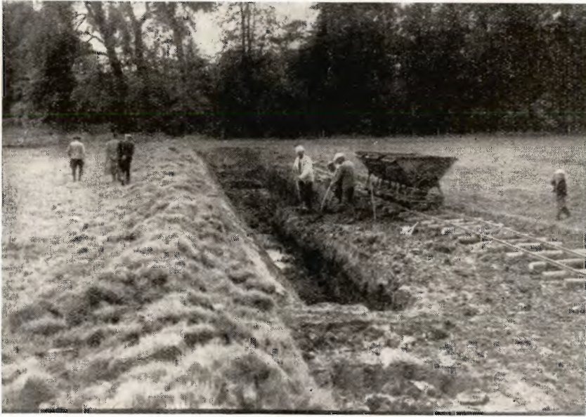
Gravning af Afvandingskanal fot. Skovborg-Petersen. gennem vandlidende Areal under Østedgaard.
