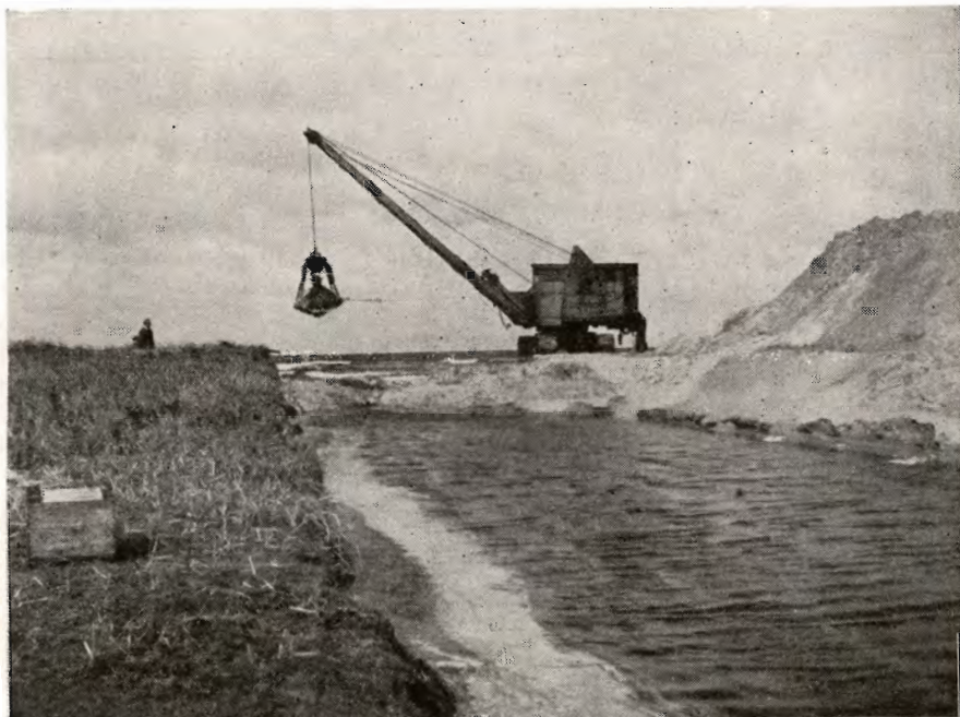
Tude Aa ved Slagelse skal have nyt Udløb til Storebælt. fot. Skodshøj. Gravemaskinen er ved at fjerne den sidste Jordvold mod Storebælt.
