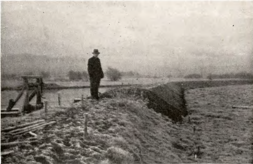
Vejle-Skibet Enge sikres nu ved Digebygning.
