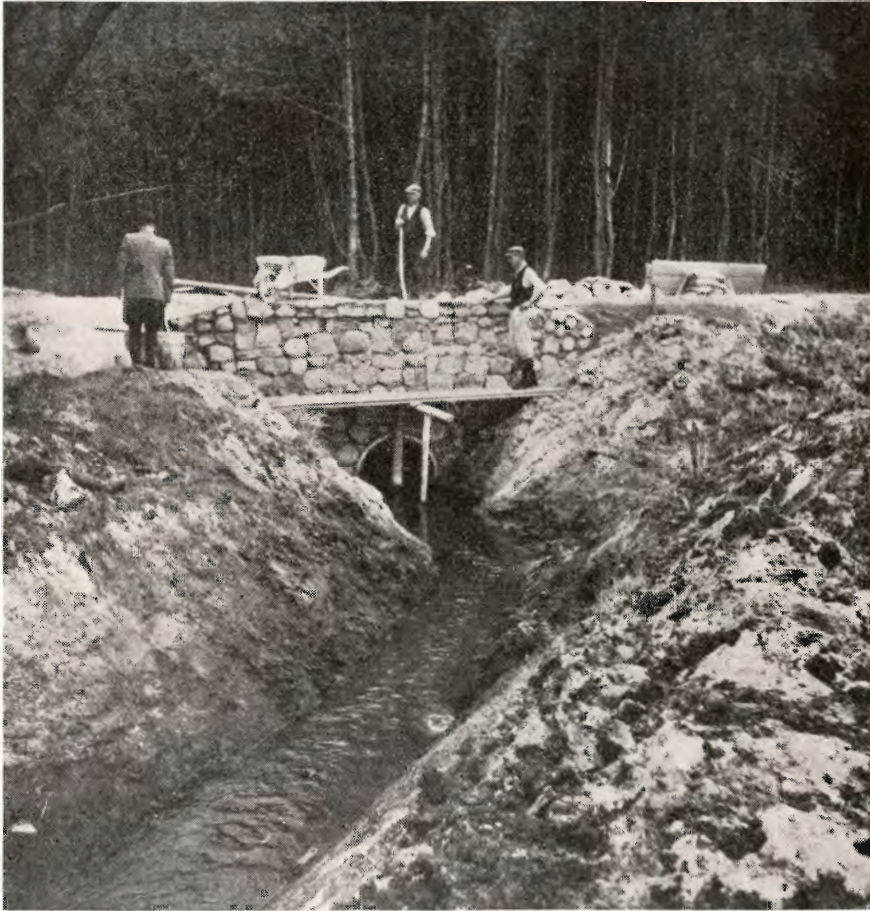
Reguleret Hovedvandløb og Fornyelse af en Vejbro fot. Skodshøj. over Vandløb Syd for Silkeborg.
