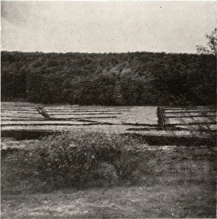
Dræningsarbejde under Udførelse i en Skovmose ved Virklund. fot. Skodshøj.
