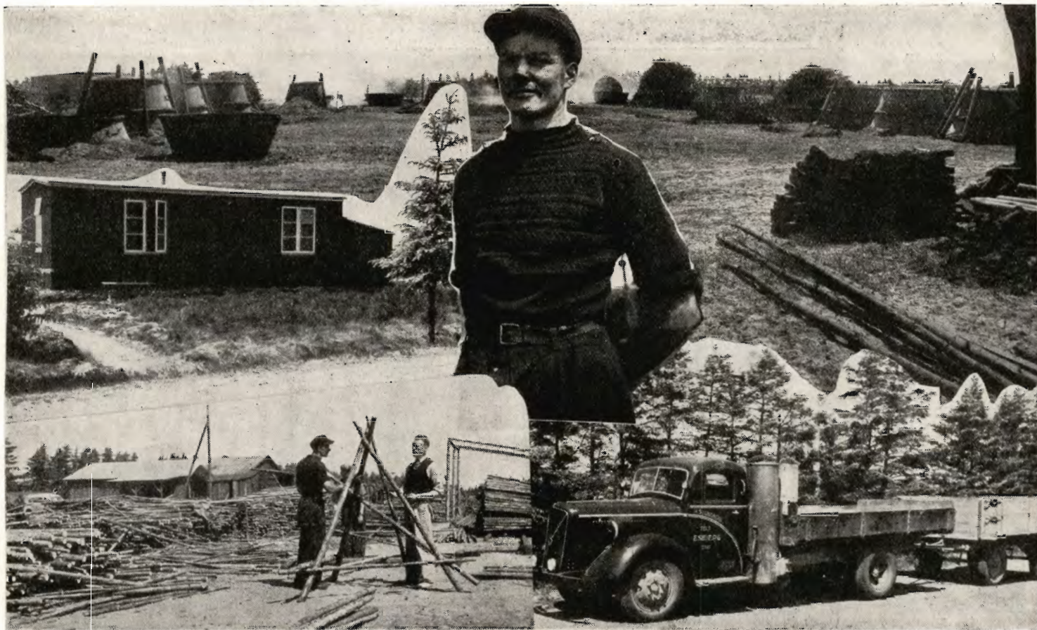
1931 fot. H. S. Fotomontage fra Hedeselskabets Trækulsbrænderi ved Brande. Øverst ses de fleste af de 14 Ovne, der nu i næsten 1 Aar har arbejdet uafbrudt. T. v. ses i Midten en Barak, hvori nogle af Arbejderne bor, nedenunder ses Trælager og Fremstilling af Hæsjer, midt i Billedet en af Kulsvierne og nederst til højre en generatordreven Lastbil fra Esbjerg, der allerede i mange Maaneder har kørt paa Trækul, den en Gang om Ugen henter i Brande.
