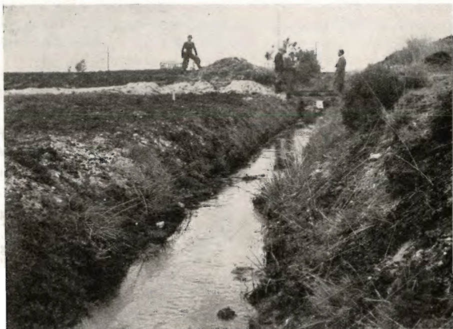
Fra Reguleringen af Vandløbet gennem den store Felding Mose ved „Lyng.“ I Forgrunden ses til v. allerede afgravet Mose, i Baggrunden en Del endnu ikke afgravet Tørvejord. Vandløbsreguleringen vil her betyde enormt forbedrede Afvandingsforhold og dermed Mulighed for bedre Udnyttelse af meget store Arealer til Tørveskær. fot. H. S.
