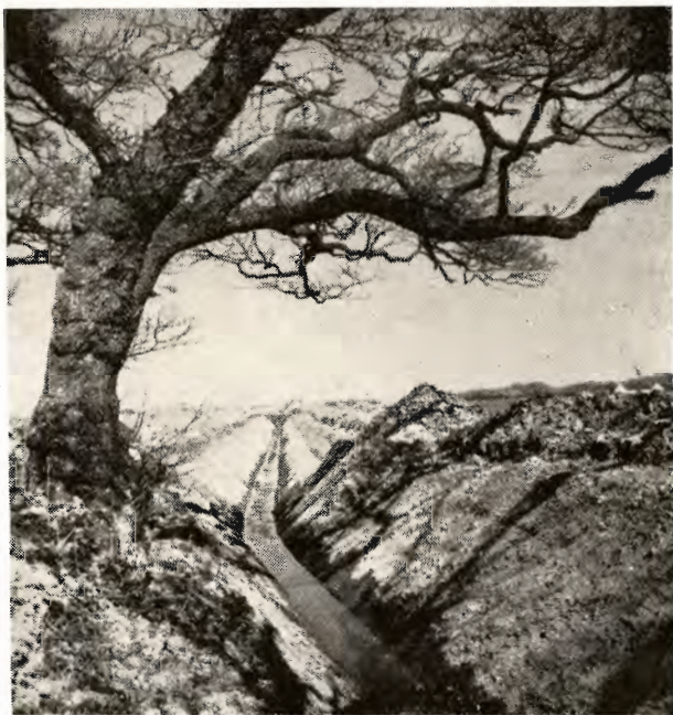
Den store Afvandingsgrøft ved Dræningsarbejdet paa Bratskov.
