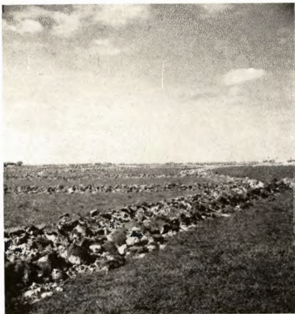
Et Dræningssystem under Udførelse.
