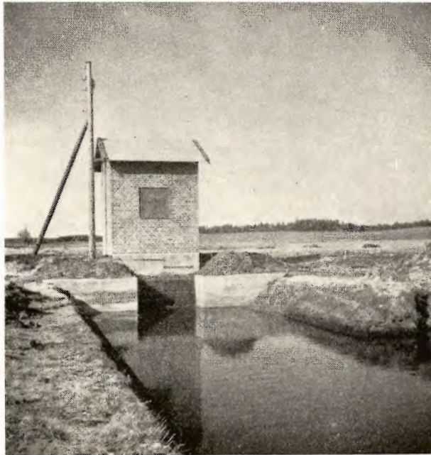
Et automatisk, elektrisk Pumpeanlæg ved Korup Sø.
