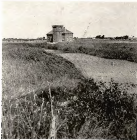
Fig. 9. Pumpestationen ved Avnø bestaar af 2 Stk. 45 HK. Elektromotorer, 2 Stk. Skruepumper, hver Pumpes Ydeevne 1000 Liter pr. Sekund ved 1,3 Meters Løftehøjde. Helautomatisk.
