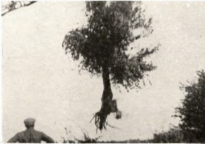
Fig. 4. Pumpekanalen maatte ogsaa føres gennem Agermark med levende Hegn. Gravemaskinen besørger det hele.
