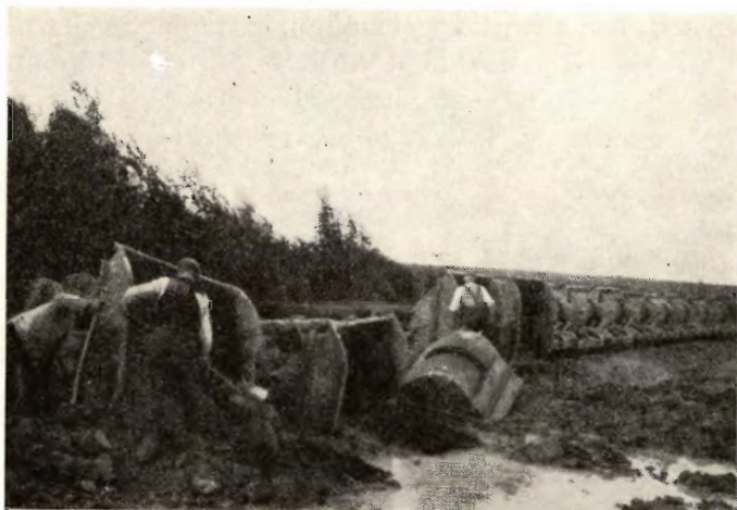
Fig. 2. En Ekstradæmning maatte bygges paa en kortere Strækning tværs over den dybe Mose, hvor der var over 6 m til fast Bund. Den faste Mineraljord forsvinder i Dybet.
