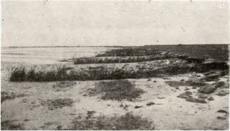
Fig. 3. Ho Bugt. Kystsikring ved Bugtens Vestside.
