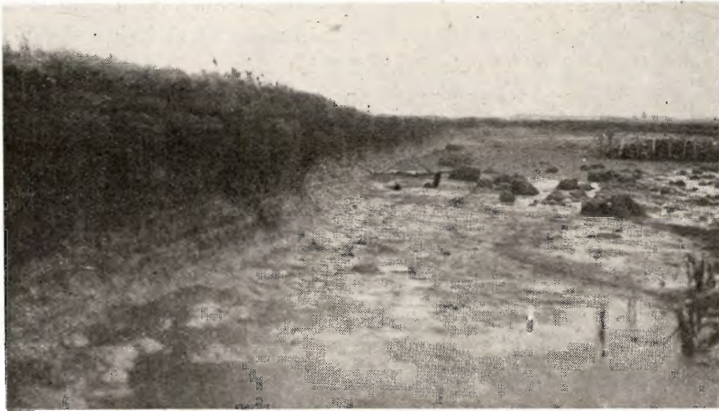
Fig. 4. Ho Bugt. Kysten nedbrydes bag Kystsikringen. Skrånten her er 1 m høj og bestaar af fed Klæg.
