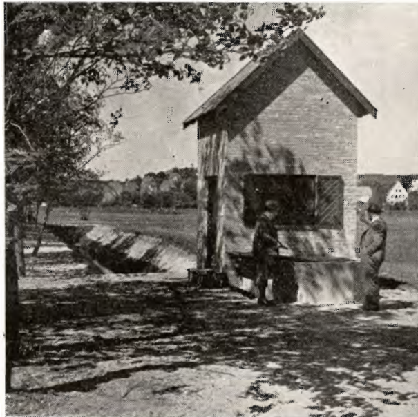
Fot. Skodshøj Pumpehus, Samlekanal og Udsigt over det afvandede, fræsede, kalkede og tilsaaede Areal, der skal være Udstillingsplads for Viborg 1940; fot. Maj 1939.
