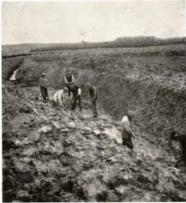
Der graves en Afvandingskanal paa Lemvigegnen.
