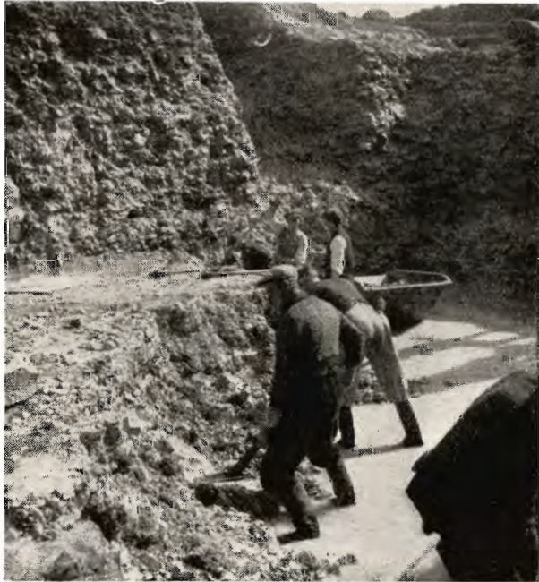
Udgravning i Kalk til en af de store nye Pumpestationer i Kolindsund.
