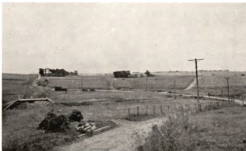
Fra Vandstandssænkningen ved Solbjerg Sø. Vejforlægning og Brobygning ved Blegind.
