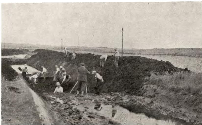
Fra Vandstandssænkningen ved Solbjærg Sø. Fredborg fot. Aalejet nærmest Søen uddybes.
