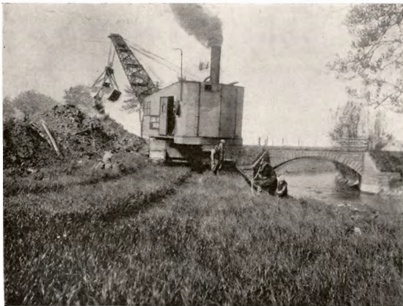
Gravemaskinen arbejder i Halleby Aa.
