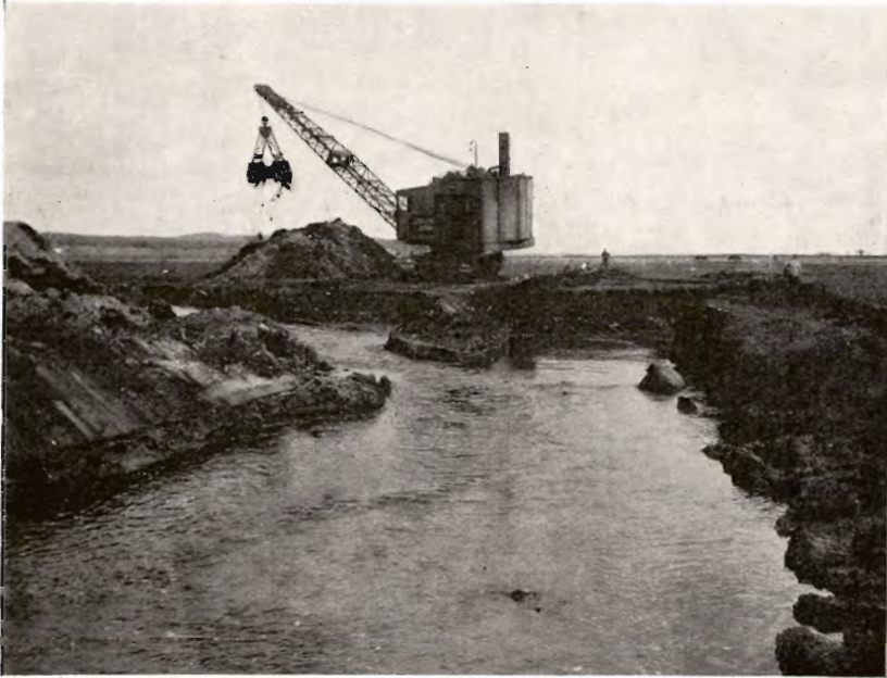
Gravemaskinen arbejder sig ind i en Gennemskæring i Halleby Aa. Til venstre ses det gamle Løb, til højre det nye Løb.
