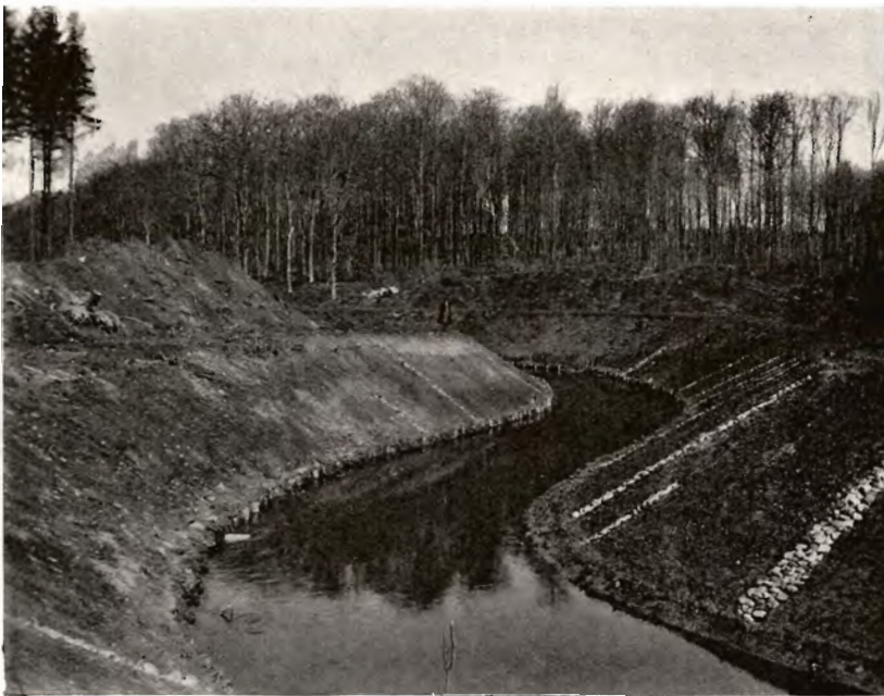
Halleby Aa nedenfor Bromølle, man lægger Mærke til de store Sikringsarbejder.
