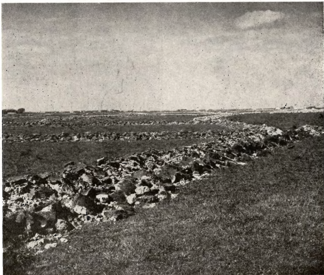
* Aabne Drængrøfter, hvor Rørledningerne endnu ikke er lagt ned.
