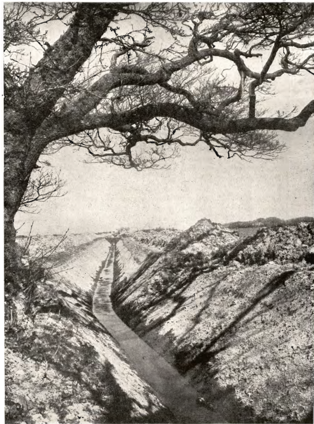
* Hovedvandløbsregulering under Udførelse.
