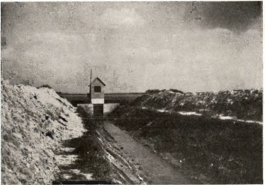
Pumpestationen ved Landting Hovedgaard.
