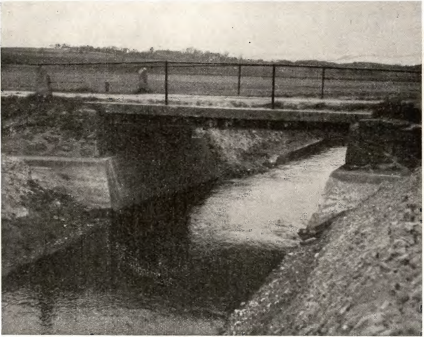
Ved Reguleringen af Granslev Aa er en af Broerne, »Faarebroen«, underbygget. fot. Skodshøj
