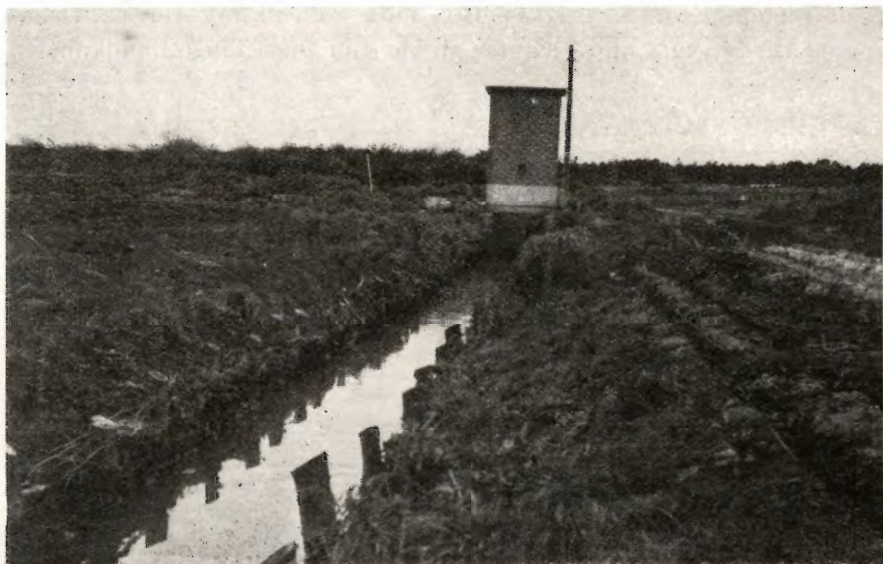
Den nye elektriske automatiske Pumpestation ved Petersholm, der er kultiveret i 1941.
