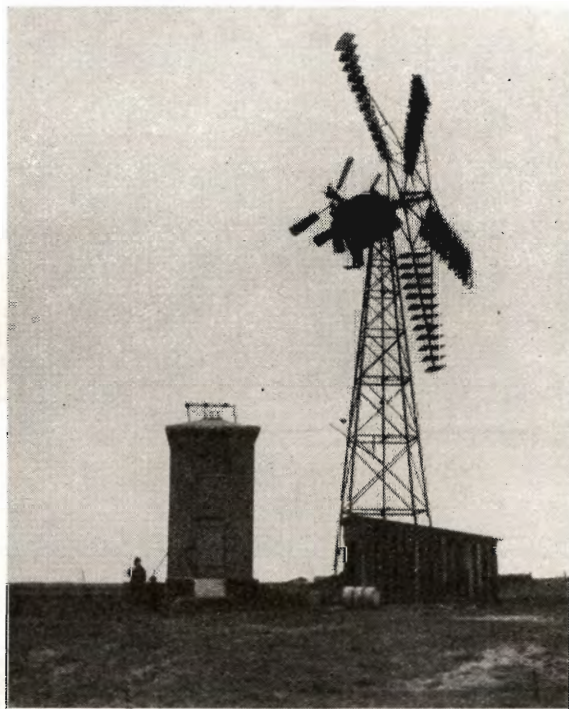
Den gamle Vindmølle og den nye elektrisk automatiske Pumpestation ved Stammoseholm.
