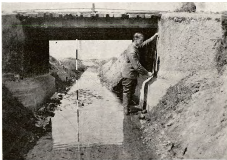
En gammel Bro efter fuldendt Understøbning.
