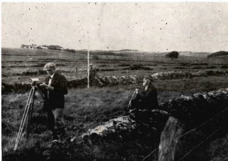
Dræning af meget vandlidende Tørvejordsarealer ved Hovedvandløbet „Lille Aa“. Arealerne har tidligere været forsøgt afvandet dels ved aabne Grøfter, dels ved Faskindræn. Fot. J. C. P.
