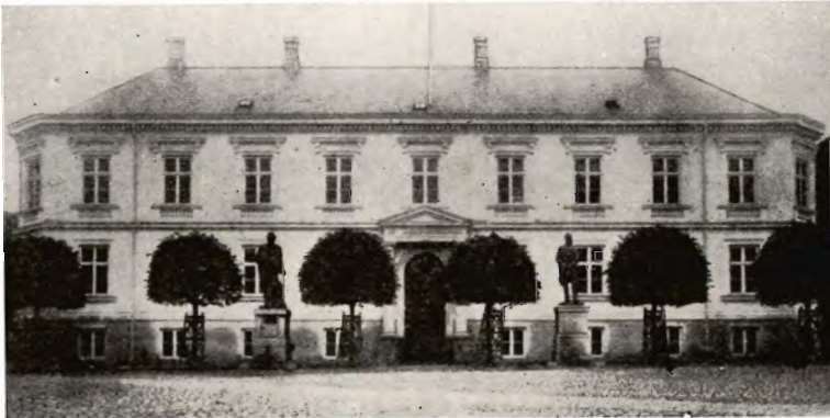
Hedeselskabet's Administrationsbygning i Viborg.
