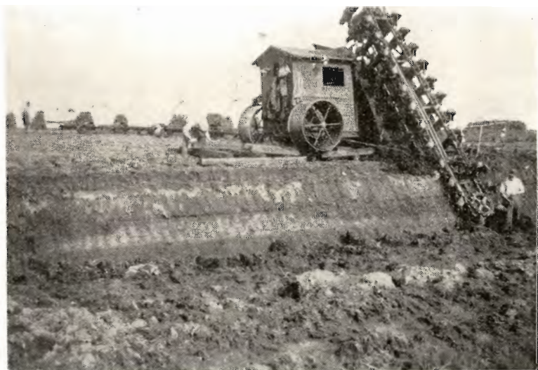
Fra Cementfabrikernes Mosebrug, Ll. Vildmose. Tørvemaskinen kører paa Mosens Overflade og opgraver Tørven ved Hjælp af en Gravelevator.
