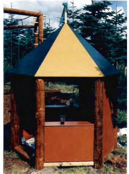
Foto 3. Legehus fra indu Udfordring med Celloc træ og plader i vandfast krydsfiner.
