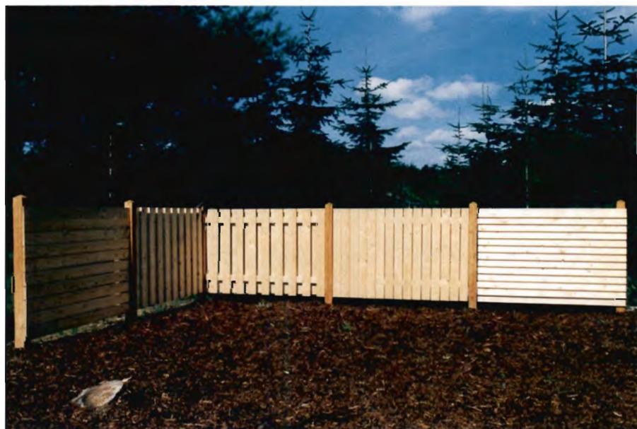
Foto 7. Fem bræddevægge som viser principperne i konstruktiv træbeskyttelse. Se teksten.
