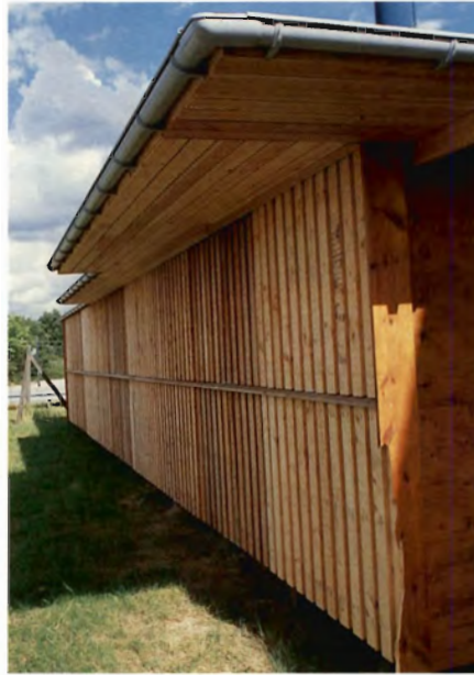
På nordfacaden er der kun anvendt tre træarter, og her prøves bl.a. endefladeforsegling, drypkant, tagudhæng og befæstelsen.
