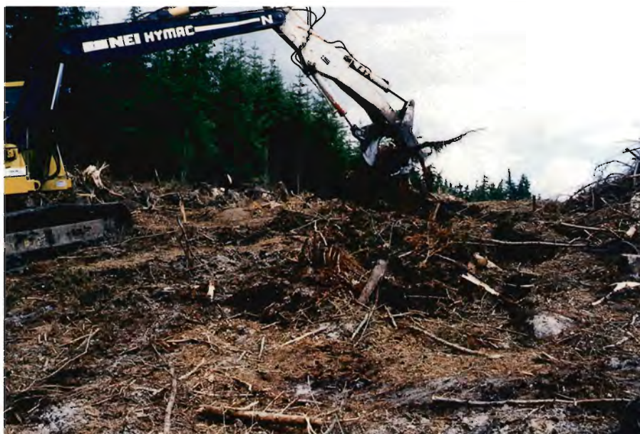
Stødene fjernes af et bæltekøretøj med et særligt aggregat.
