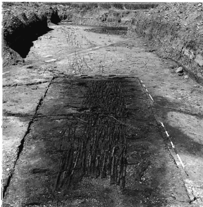
Foto 1. En hel fletværksmåtte af hasselgrene på 5 1/2 m længde. Fra fiskegærdet „Oleslyst“ ved tunnelnedkørslen på Halsskov.
