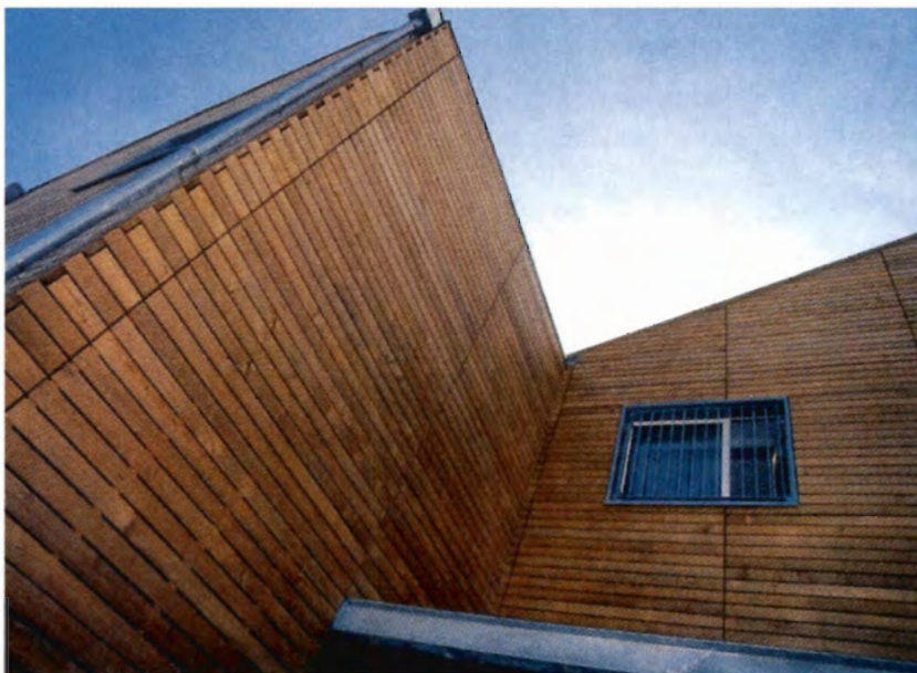
Der er brugt 310 m 2 varmebehandlet rødgran fra skovene i Risoud - op til den franske grænse - til nord- og østfacaderne.
