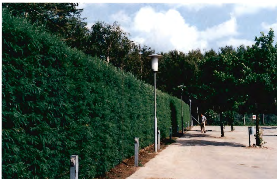
Det Grønne Element opstillet som støjdemping ved parkeringspladsen hos Midtkraft i Århus, her fotograferet en måned efter montering.
