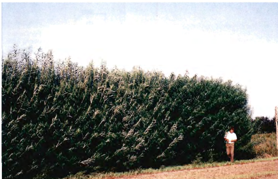
Støjskærm fem måneder efter opsætning. Den er vokset fra 2 m til en højde på 4 m.
