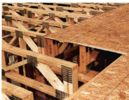
Foto 1. Amerikansk teknik med fagværksdragere i etageadskillelser.
