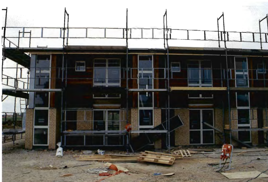
Facaden på 1. salen beklædes med amerikanske thuja-brædder.
