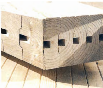
Foto 5. Der kan fræses riller i elementerne til kabelgennemføringer. Kablet føres op gennem elementet blot ved at bore
