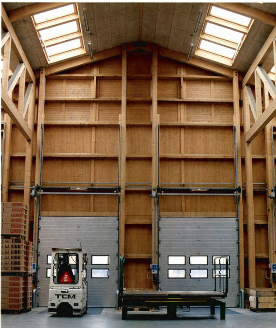
Der er skabt særdeles gode lysforhold i hallerne gennem naturligt lysindfald fra et stort antal VELUX ovenlysvinduer. Granhallerne er bygget på limtrærammer af rødgran.
