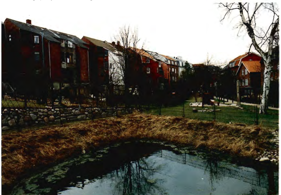
Anvendelse af uimprægneret lærk til hegnstolper, pergolaer og legepladsudstyr på det grønne fællesareal mellem boligkarréerne i landets største byøkologiske renoveringsprojekt i Kolding.
