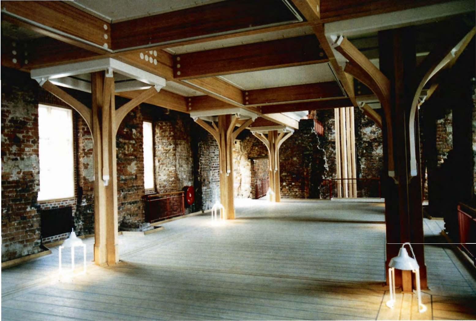
Koldinghus har i mange år delvist været en ruin. Den er nu renoveret blandt andet ved opførelse af de imponerende bærende trækonstruktioner i skovfyr (ved arkitekt Exner).
