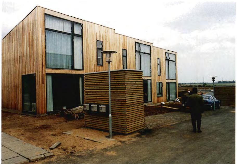
Nyopført rækkehusbyggeri med anvendelse af thuja beklædning i Vonsild, syd for Kolding. Thuja er smukt og kræver ingen vedligeholdelse. Det er lidt ærgerligt, at bygningen i forgrunden til skraldespande og postkasser er beklædt med imprægneret træ.
