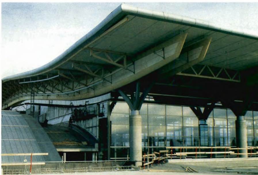
Ekspeditionsbygningen set udefra, fra ankomstsiden. Man ser tydeligt limtræet i de lange dragere og i tværdragerne, og man kan se hvordan de lange dragere har en svag S-form der kan minde om en flyvinge.
