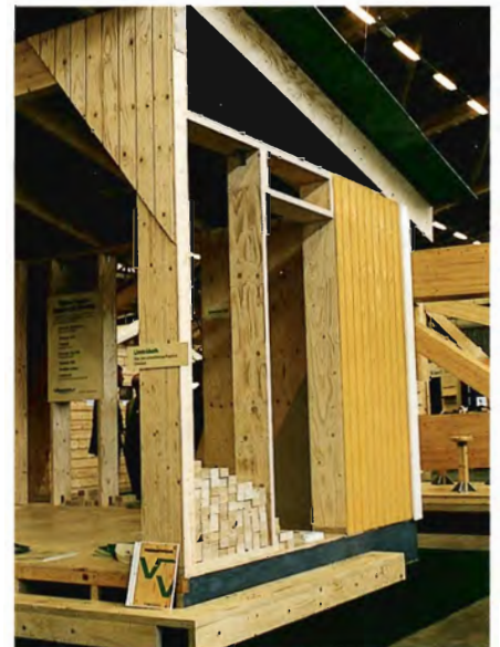
På Elmia havde Vänerply opbygget et helt hus i sine egne finerprodukter: Den forreste søjle er af limtræ, de øvrige af LVL. Beklædningen er profilerede krydsfinerplader. Vægge, gulv og tag er af krydsfinerplader, tagpladerne er svampebehandlet.
