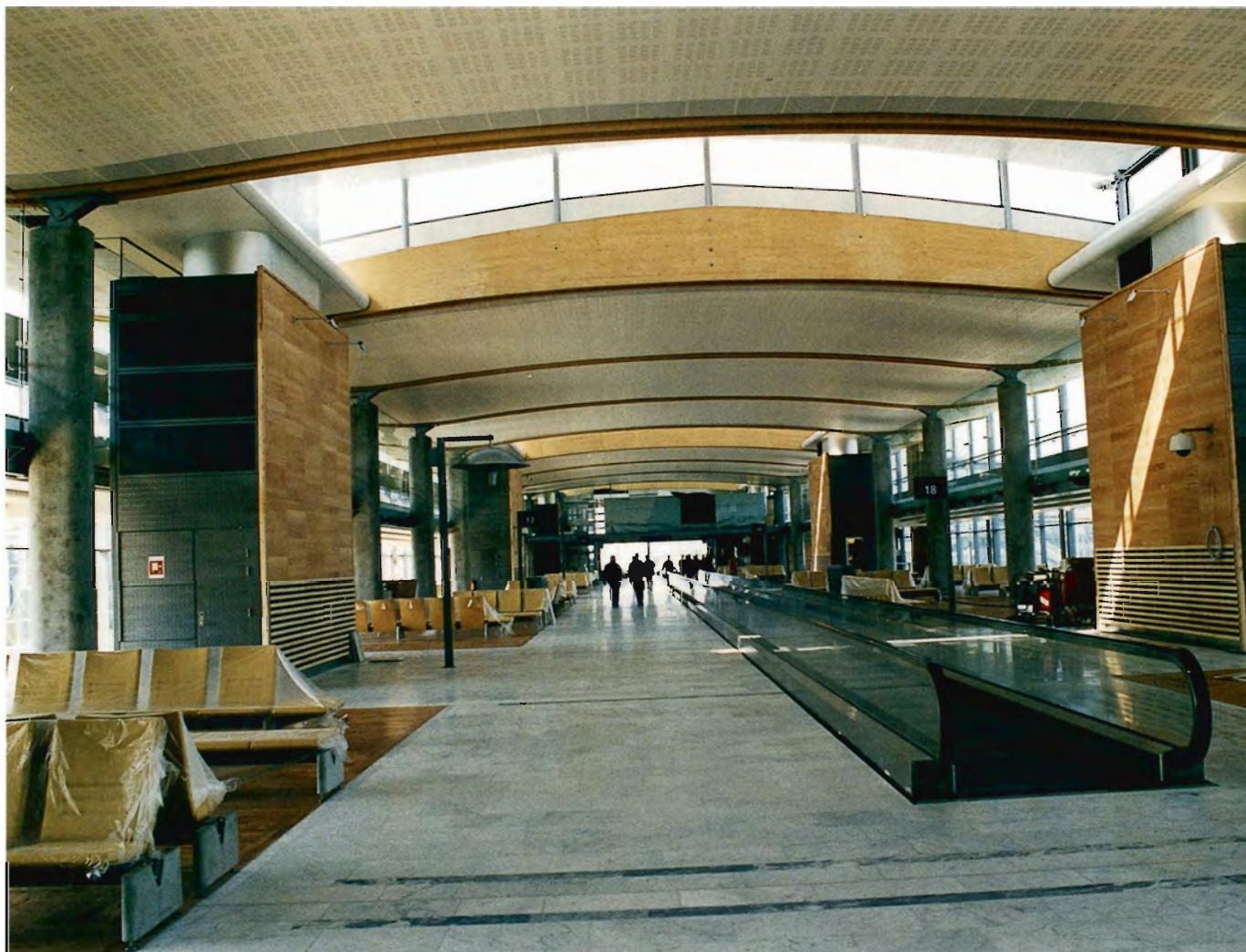
Der er lagt vægt på at skabe et lyst og venligt indtryk, her fra fingeren. Taget bæres af limtræ, og de tekniske skakter er beklædt med rødæl.
