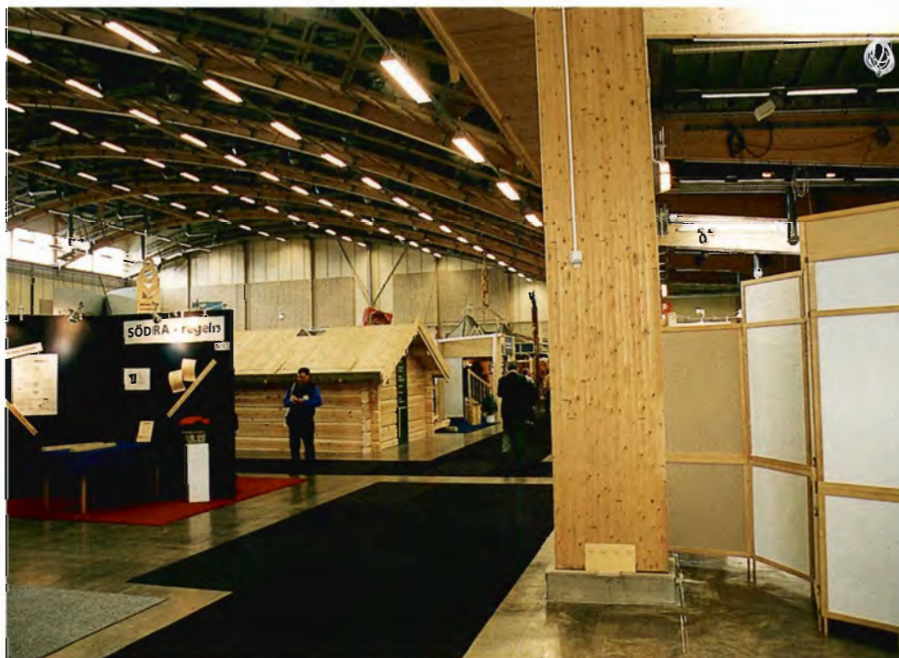
Elmia Trä blev bl.a. afholdt i en helt ny messehal hvor der er brugt træ i de bærende konstruktioner og til facadebeklædning.
