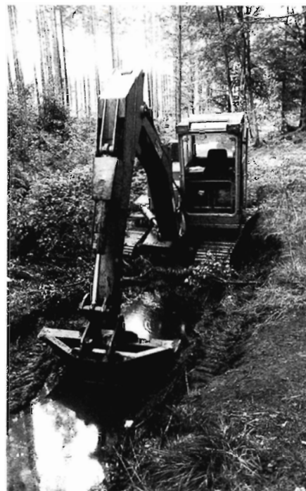
Sidegrøfterne skal vedligeholdes jævn- ligt for at undgå de alvorlige tørkeska- der der kom sidste år på bøgene på den stive lerjord. (Arkivfoto).
