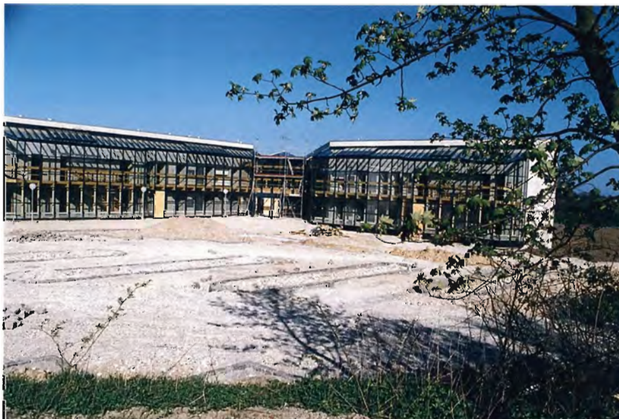
Byggeriet ses tydeligt ude fra vejen. Parkeringspladsen foran indgangen skal tilplantes med eg og vedbend. (Fotos optaget den 4. maj, inden håndværkerne var blevet helt færdige).
