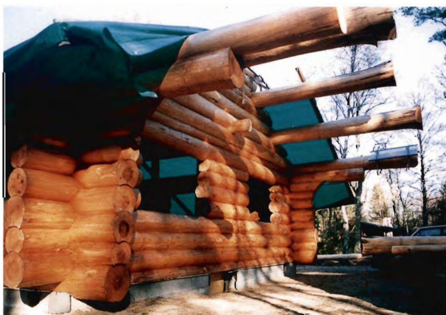
De majestætiske tagåse er på plads. Bemærk det rå look er bevaret - forhug og rodudløb ("tæer") sidder tilbage. Åsene er i lærk med roddiameter på ca. 75 cm, længde 16 meter. Lagringstid 4 år.
