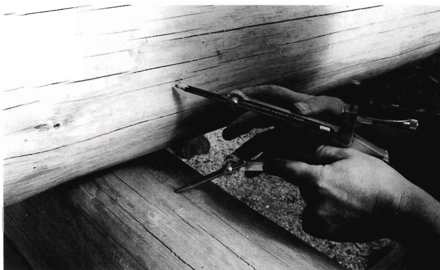
Det allerhelligste værktøj - scriberen. Den bruges til at overføre konturen af understokken til undersiden af overliggeren - vertikalt og horisontalt.
