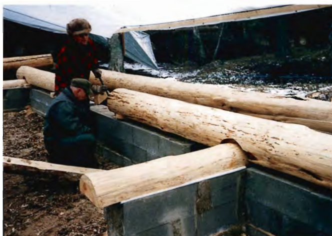
De første fag er tangentskåret og tilpasses fundamentet. Bemærk stakladen til tømmeret i baggrunden til venstre.
