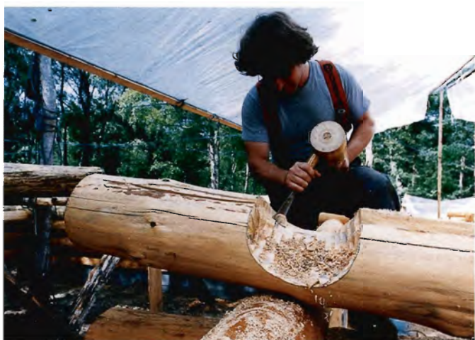
Der skal laves en dyb udskæring hvor to stammer krydser hinanden.
