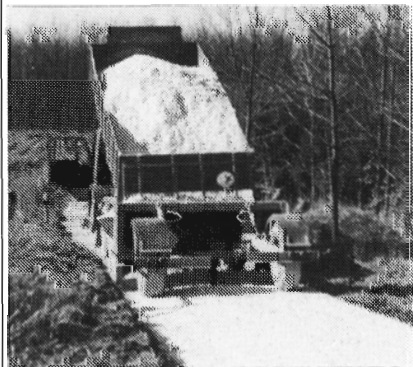
Levering og udlægning af grus, sten og andre vejmaterialer direkte fra lastbil med patentanneldt vejafretmaskine.
