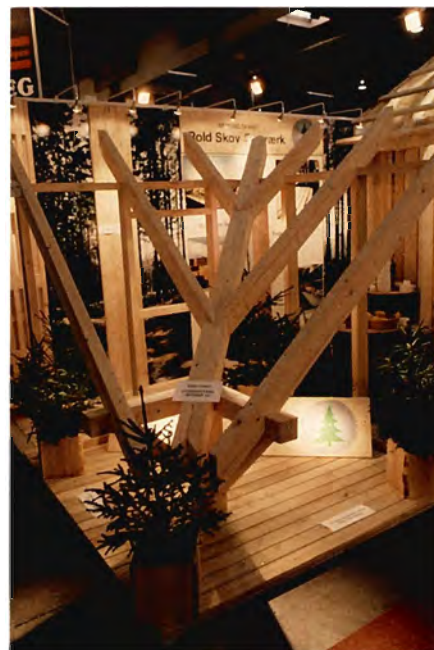
Kehlparti (del af tagkonstruktion), udført som svendestykke.
