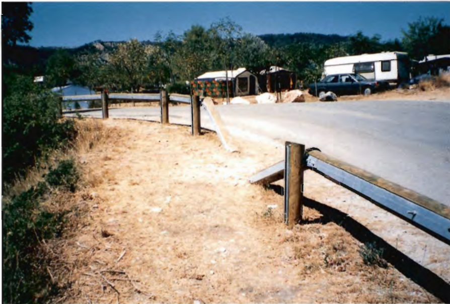
Det franske autoværn er lavet af trykimprægneret rundtræ, og på bagsiden er monteret stålbjælker til at forøge styrken.
