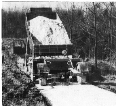
Levering og udlægning af grus, sten og andre vejmaterialer direkte fra lastbil med patentanneldt vejafrettermaskine.
