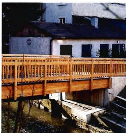
Eksempel på mindre vejbro udført i douglas .
