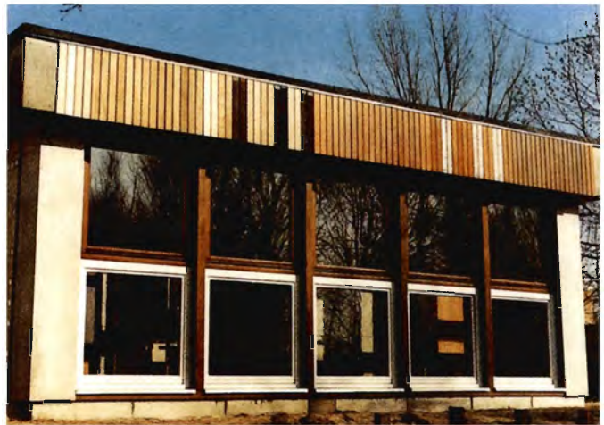
De færdige forsøgsvinduer. Vinduerne er fremstillet af fire forskellige tyske douglas herkomster, som alle var lige egnede.
