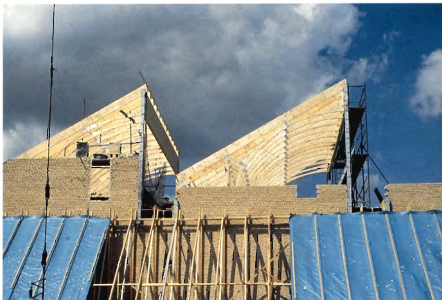
Der er også basis for at anvende træ i større omfang i byggeri. (Foto fra Sejs Kirke ved Silkeborg; den udvendige beklædning er leveret fra Palsgård Savværk. Foto: Palsgård 1990).
