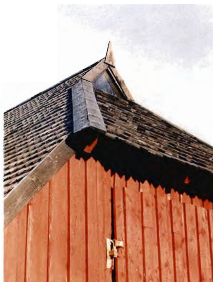
Detalje af gavlpartiet med afvalmet gavl.
