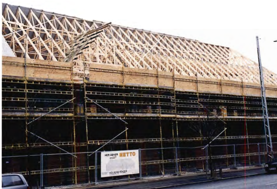
Tømmerne står for opsætning af spærfagene i nybyggeriet. Men de får ikke som i gamle dage lov til at lave hele tagkonstruktionen ude på byggepladsen.
