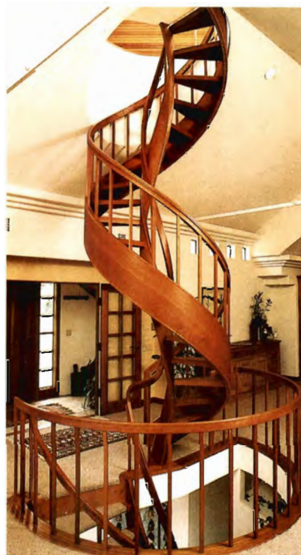
Spiraltrappe af kirsebær som bæres af spiralformede bånd i midten.
