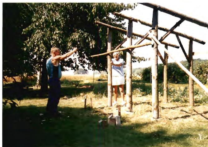
Fig. 2. Brændeskuret er ved at blive rejst - på betonklodser, der ligger i vater.
