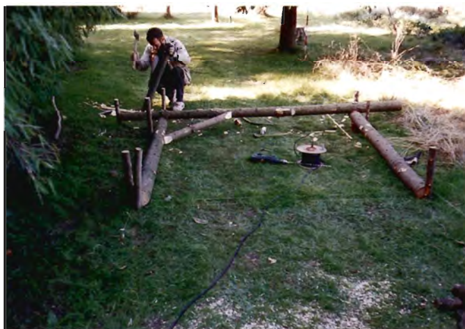
Fig. 1. Begyndelsen til et brændeskur - det første fag. Rundt træ er ikke lige tykt, så det er vigtigt, at ydersiderne og taget er plane. Det opnås ved at lægge det runde træ i en form, der bestemmer de ydre mål.
