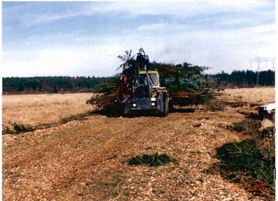
Udlægning af vejmateriale.
