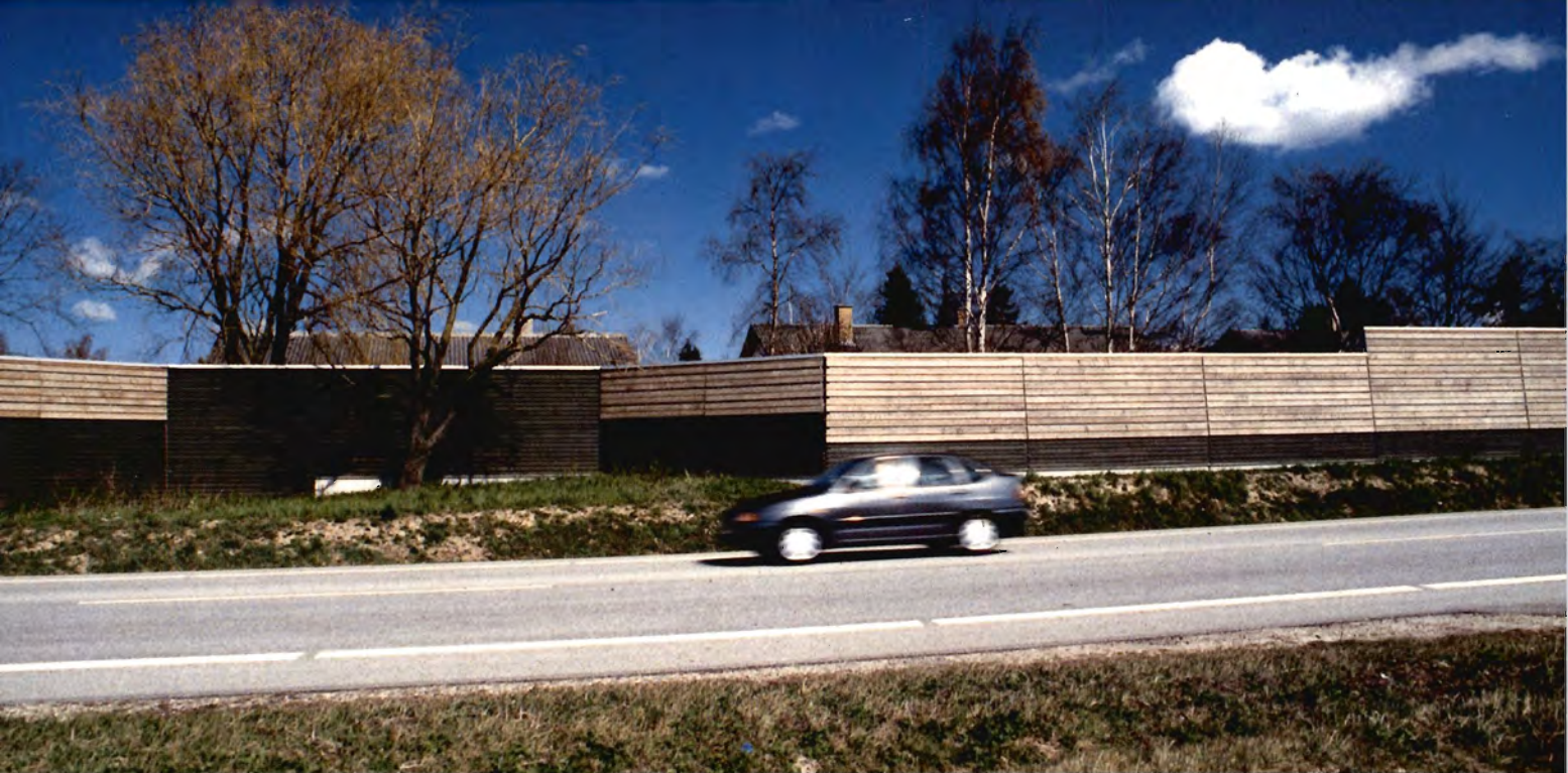
Støjskærm ved omfartsvej sydvest for Holbæk. Skærmen er tilpasset terrænet ved at gå bag om et større træ der stod i byggeplanen.
