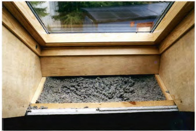
Tagvinduet er ikke helt færdigmonteret, og man ser tydeligt isoleringen af papiruld.
