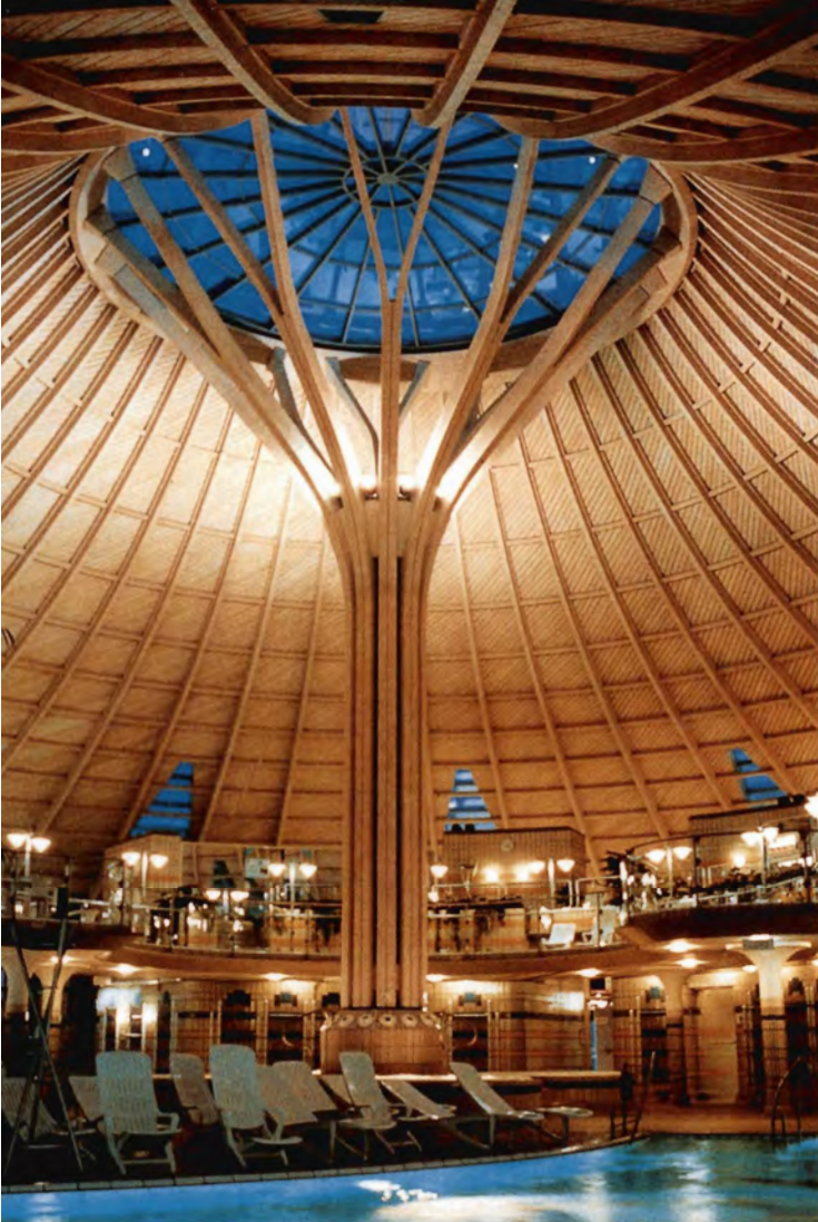
Den tyske vinder er det termiske bad i Bad Neuenahr. Taget bæres af én pille som forgrener sig som et træ. Taget bæres af 50 krumme ribber, og søjle og ribber mødes i en ring med en diameter på 12 m.
