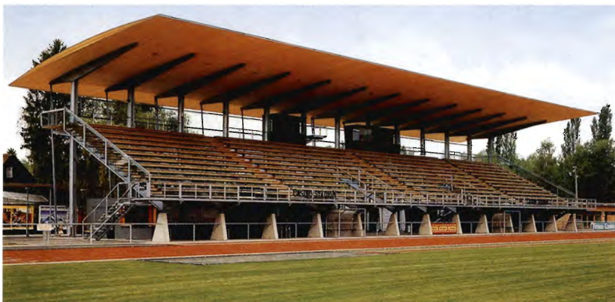
På Bodenseestadion i Bregenz i Østrig beskyttes tribunen af et tag på 17 x 57 m, opbygget af to lag træ. Undersiden er en trelags krydsfiner af douglas. Sæder og trapper består ligeledes af limtræ af douglas.
