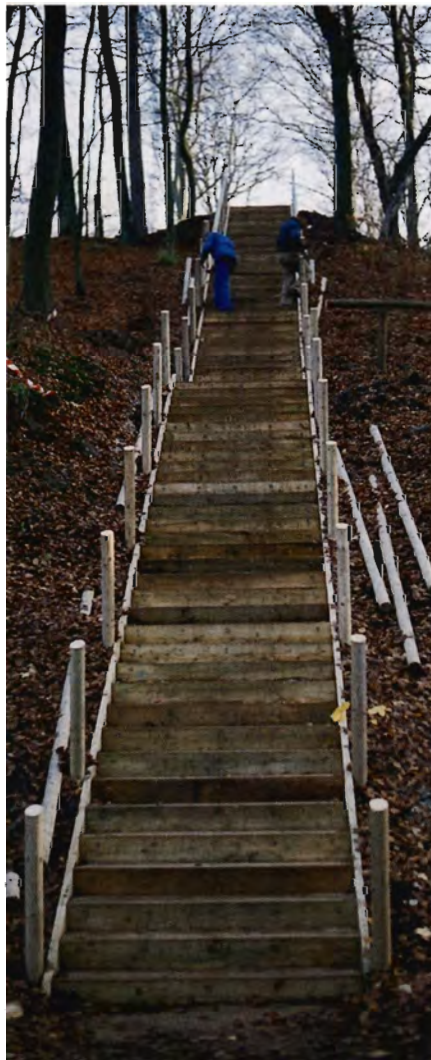
Foto 1. Trappe under opbygning forår 1995.
