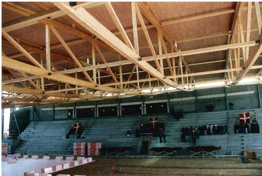
Fra rejsegildet i Rødovre Skøjte Arena. Man ser tydeligt de lange cigarformede spær og tagelementerne hvis underside er træbetonplader. Hallen er på 4.000 m 2 og kan rumme 3.500 tilskuere.
