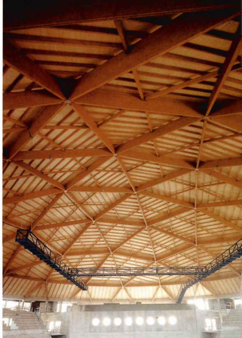
Sportshallen i Busto Arsizio i Italien er dækket af en kugleformet trækuppel, formet som et netværk af trekanter. Diameteren er 69 m, og taget dækker 3900 m 2 .
