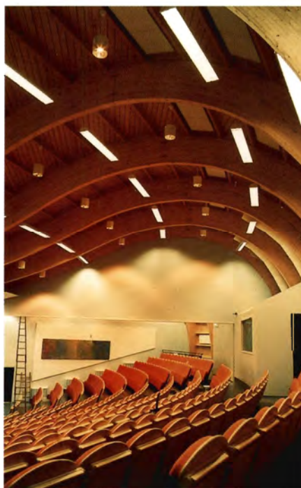
Det norske vinderprojekt er auditoriet i Sygeplejeskolen i Gjøvik. Limtræsbeuerne spænder over 18 m, og der kan være 380 i lokalet.
