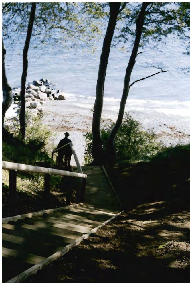
Foto 3. Vores nyeste trappe. Lige oven for personen er der lavet en repos, dels fordi skrænten stiger mindre, dels fordi trappens forløb ændres.
