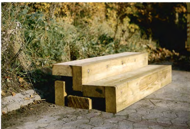
Foto 2. Trinene er udskåret af lærk fra vores egne skove. (Hulrummet under trinene vil være fyldt med sand eller jord - her er der i stedet anbragt sveller for at vise hvordan de færdige trin ligger).
