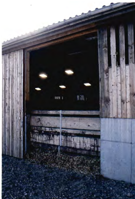
Dybstrøelsen i stierne holdes på plads af kraftige bjælker af elmetræ.
