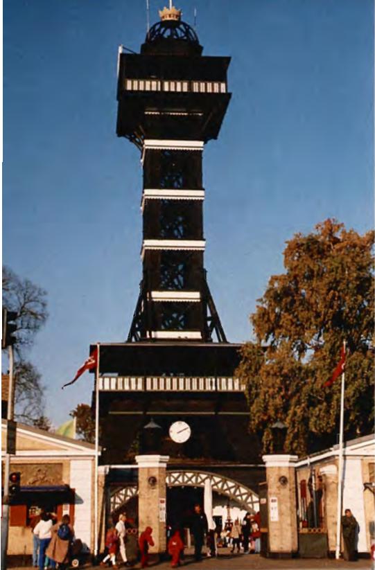
Tårnet i Zoologisk Have i København er bygget af pommersk fyr i 1905. Arkitekten Th. Hirsch har ladet sig inspirere af Eiffeltårnet der var bygget 6 år før (se især svajet i nederste del af tårnet). Der skete en større renovering af tårnet i 1974, men ellers har det holdt sig fint. Og det kan stadig holde til at svaje 80 cm i kraftig blæst.
