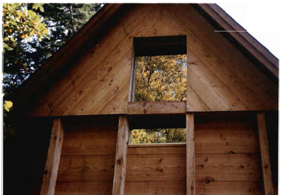
Ved den senere udvidelse af køkkenet er søjlernes endeflader skjult af gavlbeklædningen.
