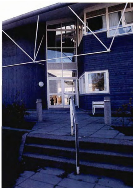
Indgangen er tydeligt markeret ved den tilbagetrukne indgangsdør, og trappeåbnet til venstre er fremhævet ved lodrette brædder.
