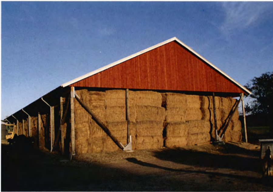
Stolpelade til frøgræshalm på Barritskov med søjler af kasserede telefonpæle.
