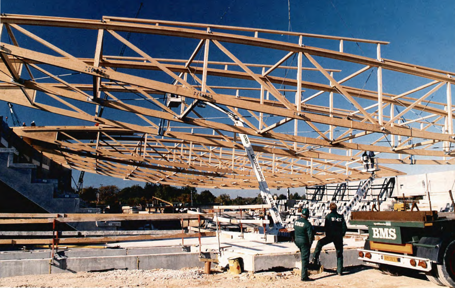
Skøjtehallen efter montage af hovedparten af gitterspærerne af limtræ.
