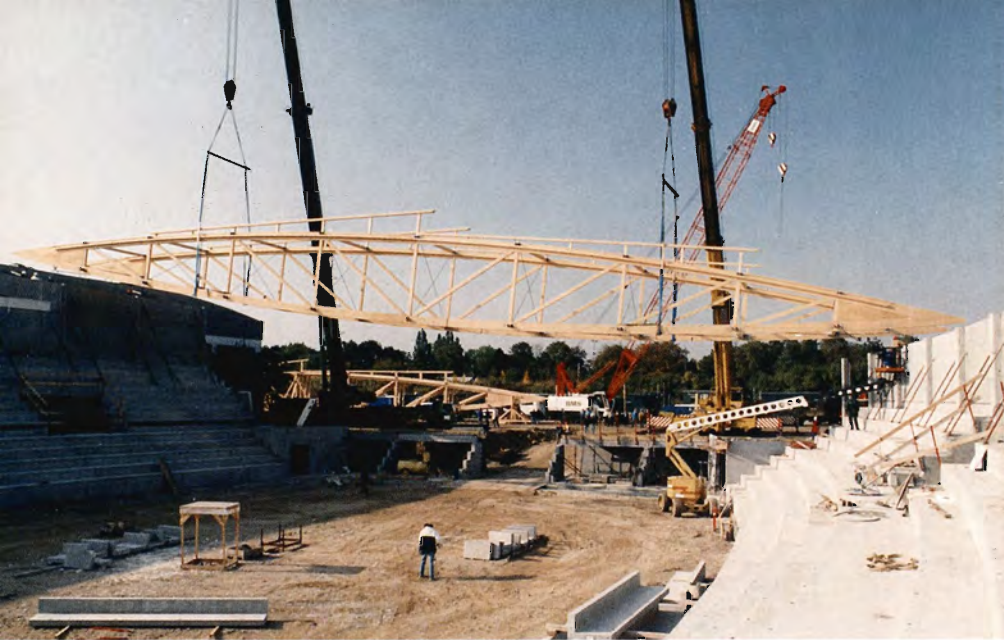
Limtræsdragerne løftes på plads af to af de største mobilkraner i Danmark. Af hensyn til stabiliteten skal der monteres vindkryds mellem to spær i hver ende af hallen. Denne montage foregår på jorden, og de to spær på ialt 18 tons løftes på plads på én gang.
