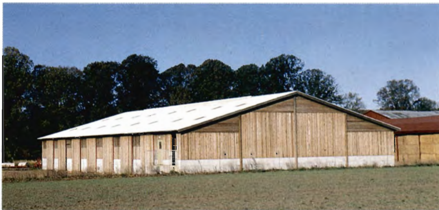
Slagtesvinestald på Bidstrup med facade i gran og et „mønster“ i gavlen.
