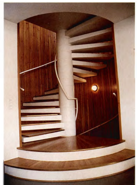
Den indvendige spindeltrappe er belædt med dansk douglas.
