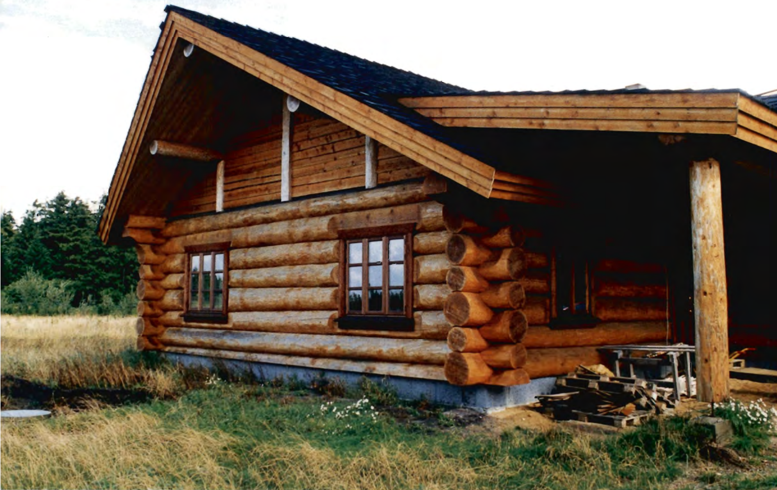
Sydgavlen med stort udhæng for at beskytte huset.
