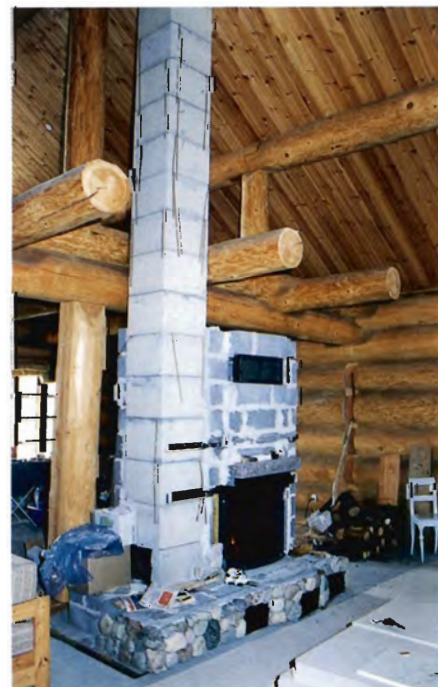
Ovnen midt i stuen kan opvarme stue, spisekøkken og hems.
