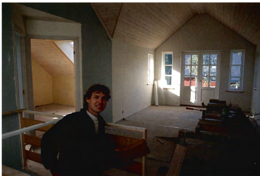
2. Indvendigt er der ludbehandlet fyr i loftet og gipsplader på væggene - en kombination af dansk byggestil og norsk træ, fortæller entreprenør Michael Albertsen.
