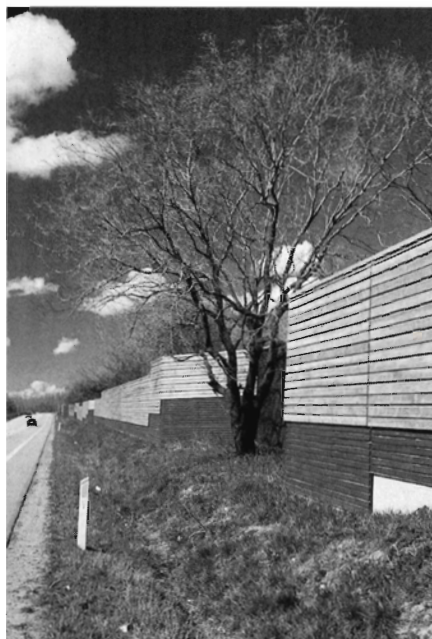
Støjskærm af træ, her på omfartsvej ved Holbæk. Skærmen er ført udenom et træ der stod i byggelinjen.
