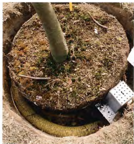
Fig. 7. Bytræer belastes hårdt, omgivet af komprimeret jord. Med beluftningsudstyr kan der komme luft ned i jorden til gavn for rødderne.
