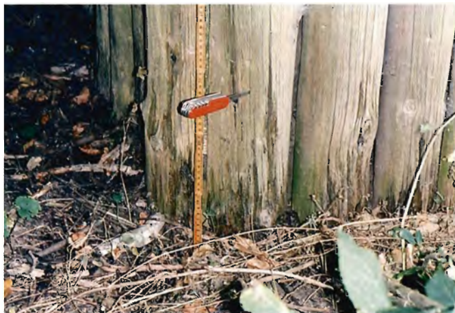
Figur 4. SV hjørnet set fra S. Skønt klædning og stolpe har samme jordkontakt som SØ-hjørnet, er råds-kader og tørrerevner langt mindre, takket være skygge og læ fra V og delvis SV. Endvidere ses ikke spor efter mekaniske beskadigelser.
