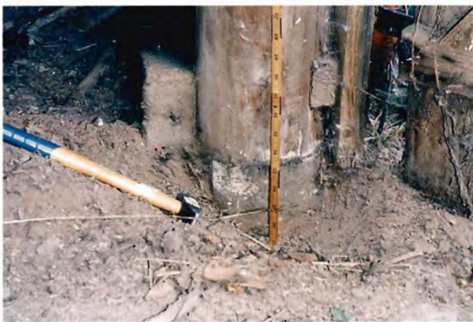
Figur 7. Nordlige portstolpe i østgavlen. Den runde stolpe var oprindelig jordgravet, men jorddelen blev i 1907 kappet af på grund af råd og erstattet af en sten, senere en betonklods. Trods jordkontakten strækker råds-kaden sig kun få cm op i en iøvrigt sund og klangfuld stolpe.
