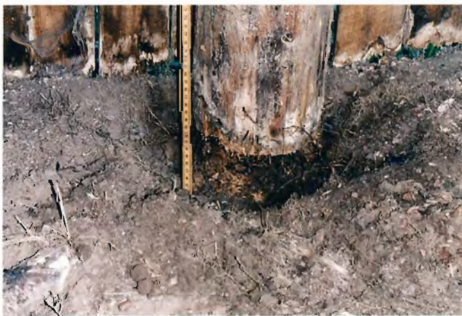
Figur 8. Nordvæggens stolpe nr. 2 fra Ø mod V. Stolpen var oprindelig jordgravet. Den mangler nu kontakt til den i 1907 indsatte sten, og hænger i remmen med nedbøjning af taget til følge. Råds-kaden går kun få cm op i stolpen, som derover er sund.
