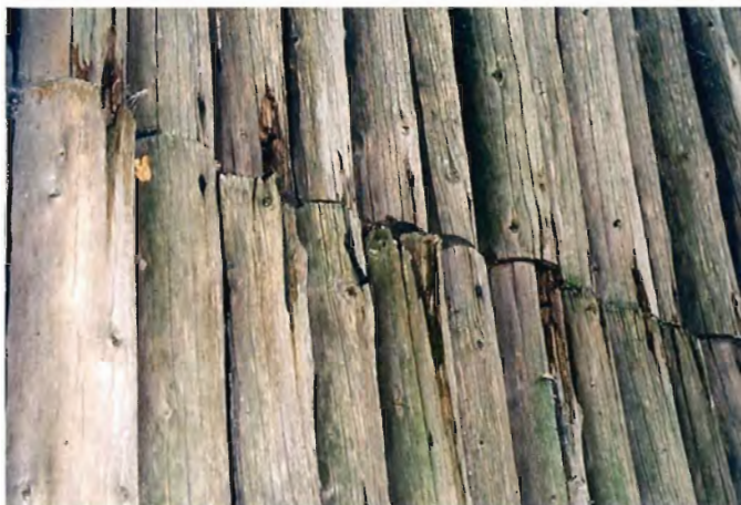
Figur 5. Vestgavlen. Karakteristiske råds-kader over og under stød. Bemærk de små tørrerevner.
