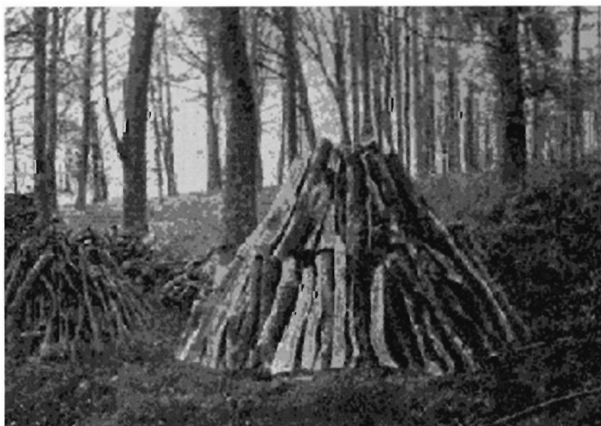
Fig. 1. Opsætningen af brændet er færdig, og milen mangler kun at blive dækket med granris og kulster, før den kan antændes. Foto taget af A. Oppermann den 9. august 1928 på Nødebo Distrikt under forsøg med trækulssvidning i mile (A. Oppermann 1928-30).
