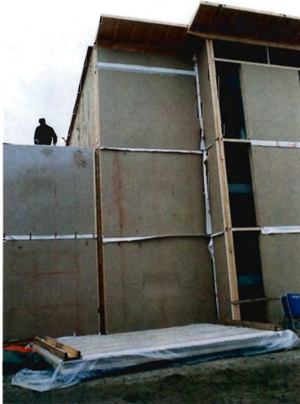
Foto 2. Blok 3 er ikke så langt fremme. Her ses vægelementerne der leveres klar til montage med isolering og gipsplader fra Palsgård Træ A/S.
