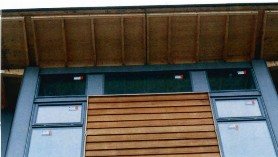
Foto 12. Et stort tagudhæng skal beskytte facaderne mod regn.
