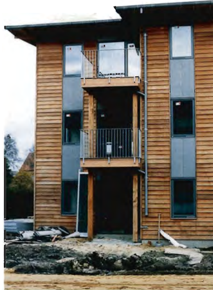
Foto 3. Over hvert vindue er monteret en zinkplade for at undgå brandsmitte ved en eventuel brand i lejligheden. Det store tagudhæng skal beskytte træet mod fugt.
