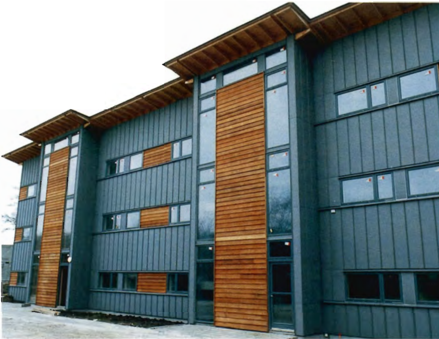
Foto 11. På nordsiden er der næsten udelukkende anvendt zinkplader på facaden. Det skyldes dels risikoen for brandsmitte, dels æstetiske grunde.
