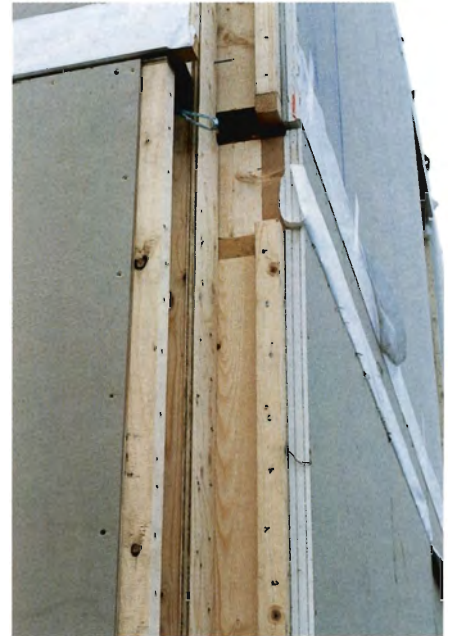
Foto 5. For at undgå sætning i ydervæggene er der indskudt en lodretstående klods mellem de to vægelementer. Det betyder at vægten af det øverste element overføres gennem klodsens og ikke gennem en vandret gulvbjælke (som svinder).
