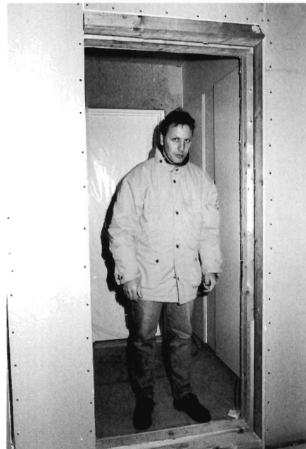
Foto 10. - Der er i høj grad tale om et udviklingsbyggeri, fortæller entreprenørleder Per-Ole Mylund Pedersen. Vi har skullet finde mange nye metoder undervejs i byggeprocessen, bl.a. omkring samlingerne mellem de enkelte elementer. Men vi er blevet dygtigere undervejs, for montagetiden er nedsat med 20% fra blok 1 til blok 3 som vi er i gang med nu.
