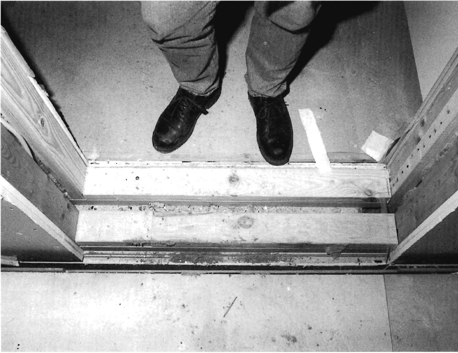
Foto 7. Der er dobbelte vægge mellem lejligheden og trappetårnet. Derved mindskes risikoen for sætning hvis de to vægge ikke svinder lige meget. Trappeafsatsen ses forrest i billedet; den er fastgjort til elevatorårnet og ikke til trævæggen.
