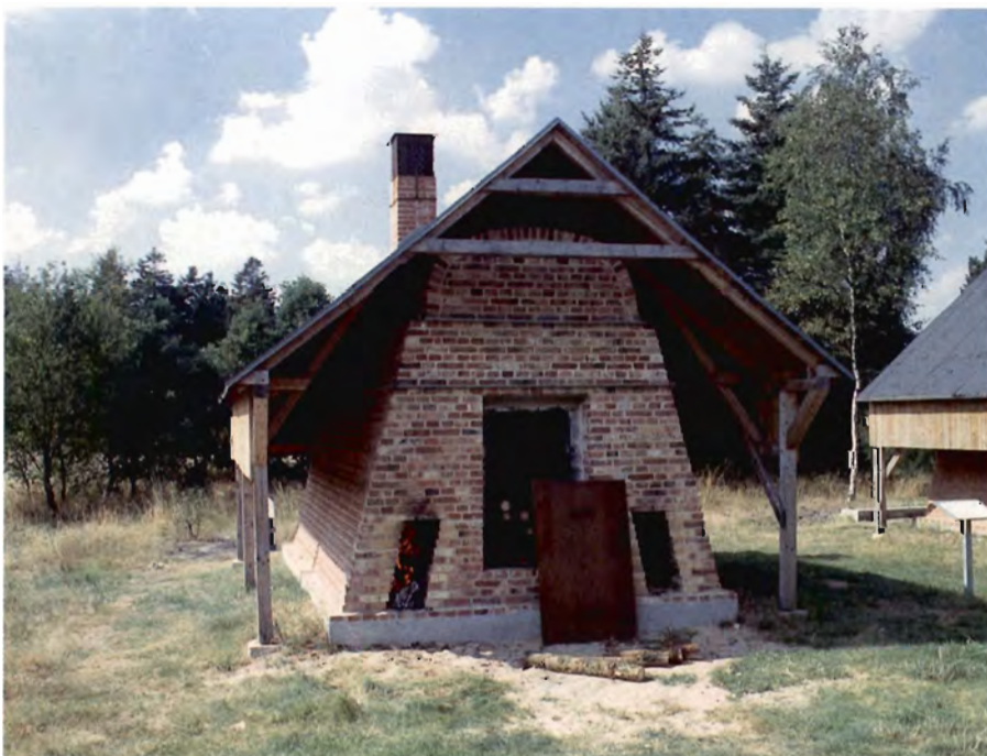
Fig. 4. I Hesselvig Plantage er opstillet en model af de ovne som blev brugt til at fremstille tjære.
