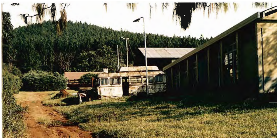
Verdensbanken har finansieret en grundig renovering af skolens bygninger. De fysiske rammer er høje efter ugandisk standard
