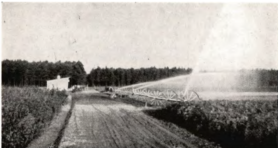
Fig. 10. Vandingsanlæg med rullende sprederledning.
